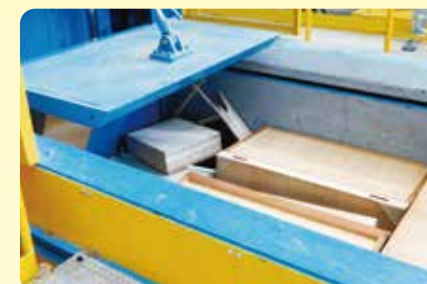
可燃性の粗大ごみは、破碎装置で砕いてからごみピットに投入します。
