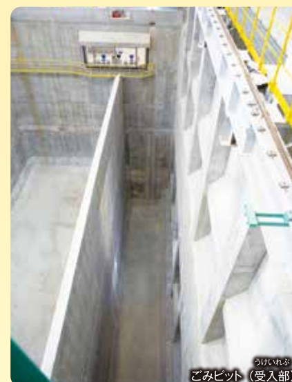
ごみ投入扉から投入したごみは、 ごみピットの受入部に入ります。
