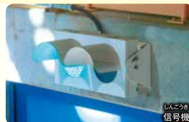
毎日、たくさんの収集車や一般の車がごみを投入しにきますが、信号機で投入できる扉を案内したり、車止めで落ちないようにしたり、安全に作業ができるようになっています。
