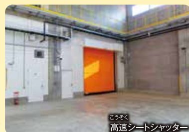
スライドドアと高速シートシャッターの2つの扉を通してプラットフォームに入ります。エアカーテンは、空気の流れで壁をつくる機械です。2つの扉と空気の壁で臭いを外に出しません。
