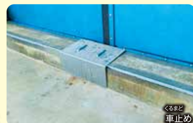
毎日、たくさんの収集車や一般の車がごみを投入しにきますが、信号機で投入できる扉を案内したり、車止めで落ちないようにしたり、安全に作業ができるようになっています。
