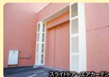
スライドドアと高速シートシャッターの2つの扉を通してプラットフォームに入ります。エアカーテンは、空気の流れで壁をつくる機械です。2つの扉と空気の壁で臭いを外に出しません。
