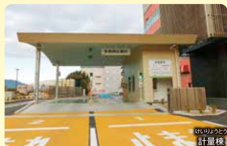
計量棟になると、車ごとのれる計量機で 車とごみの重さを計ります。
