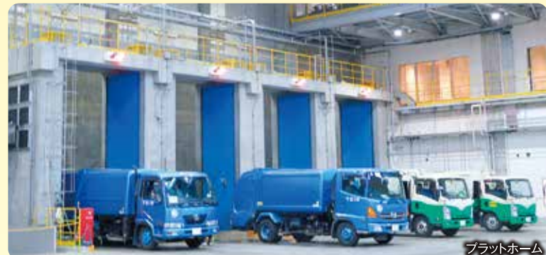
収集車がごみ投入扉に近づく、扉が自動的に開きます。 収集車は、車の後から、ごみピットにごみを投入します。
